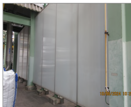
ภาพถ่ายที่ 2.2.1-23 บริเวณที่มีการติดตั้งอุปกรณ์ เพื่อลดความดังเสียงและป้องกันเสียง
