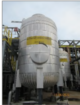
ภาพถ่ายที่ 2.2.1-8 หอถ่านกัมมันต์สำหรับดูดซับซัลเฟอร์
