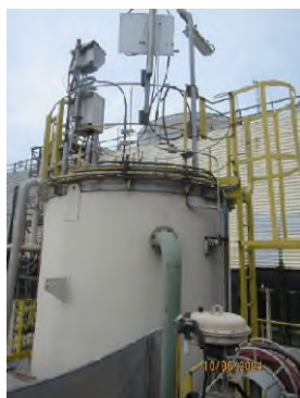
ภาพถ่ายที่ 2.2.1-16 ระบบบำบัดน้ำเสียของส่วนผลิต CO
