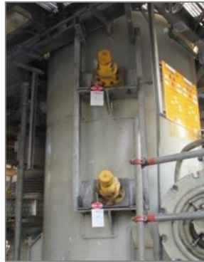
ภาพถ่ายที่ 2.2.1-6 ระบบ Interlock สำหรับหยุดการป้อนโค้ก
