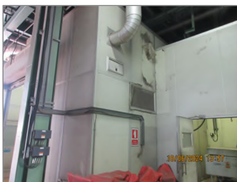
ภาพถ่ายที่ 2.2.1-23 บริเวณที่มีการติดตั้งอุปกรณ์ เพื่อลดความดังเสียงและป้องกันเสียง
