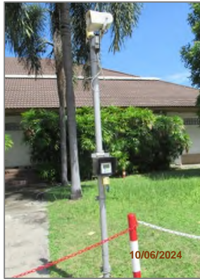
ภาพถ่ายที่ 2.2.1-50 เครื่องตรวจจับ CO แบบต่อเนื่อง (CO Concentration Online) ในส่วนผลิต CO
