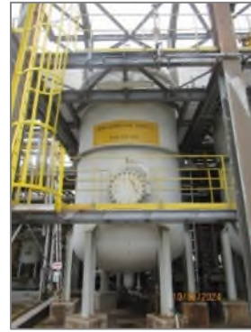
ภาพถ่ายที่ 2.2.1-7 หอเหล็กไฮดรอกไซด์ สำหรับกำจัดซัลเฟอร์
