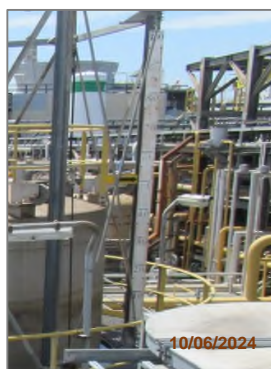
ภาพถ่ายที่ 2.2.1-40 อุปกรณ์วัดระดับแบบวัดเฉพาะ จุดแบบ Local Scale
