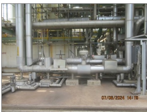
ภาพถ่ายที่ 2.2.1-38 ติดตั้งระบบ Safety Valves และฉนวนหุ้มท่อส่งไอน้ำในพื้นที่โครงการ
